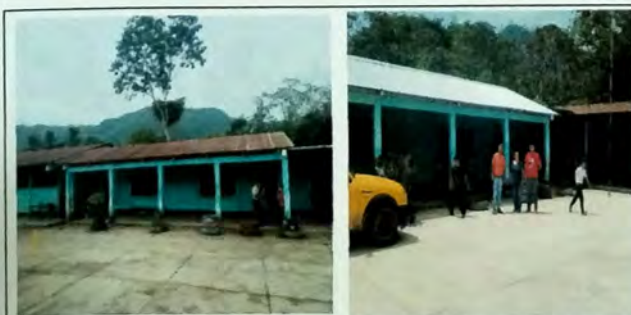
Foto 5: Vista Exterior Frontal de Modulo de aulas B se cambio cubierta de lamina de zinc por lamina troquelada cal 26. Se sustituyo estructura de madera en mal estado por estructura de metal a base de vigas y costaneras
