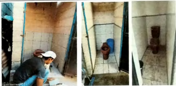
Foto 8: Vsta interior de cubiculos de servicios sanitarios donde se intalo azulejo y piso ceramico, asi mismo se intalaron sanitarios nuevos.
