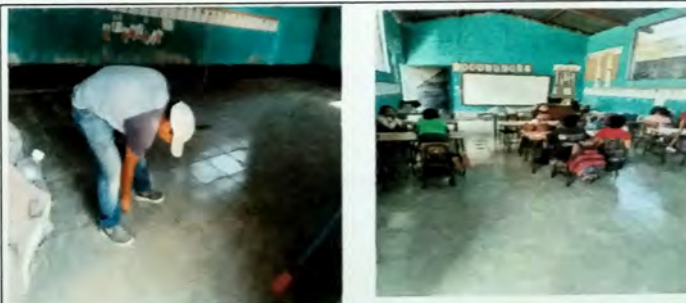
Foto 12: Vista interna de modulo de aula en interior de la misma. Donde se aprecia el piso ceramico que se instalo.
