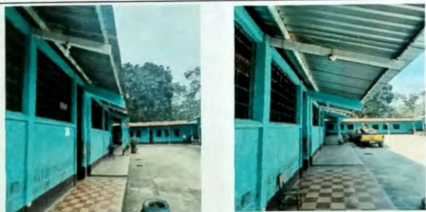
Foto 3: Vista corrido de Modulo de aulas C se cambio cubierta de lamina de zinc por lamina troquelada cal 26.
