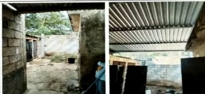
Foto 10: MODULO A servicios sanitarios, se instalo estructura de metal y lamina troquelada cal 26. Se remozaron las puertas de metal que estaban en mal estado.
