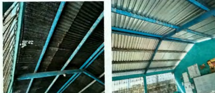
Foto 4: Vista Interior de Modulo de aulas C se cambio cubierta de lamina de zinc por lamina troquelada cal 26.
