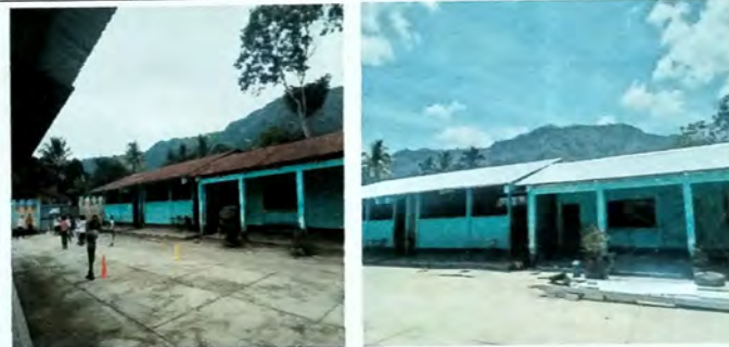
Foto 2: MODULO DE AULAS C Y B. Vista exterior de Modulos de Aulas que se cambio cubierta de lamina de zinc por lamina troquelada cal 26. Modulo B de la derecha se sustituyo estructura de madera en mal estado por estructura de metal.
