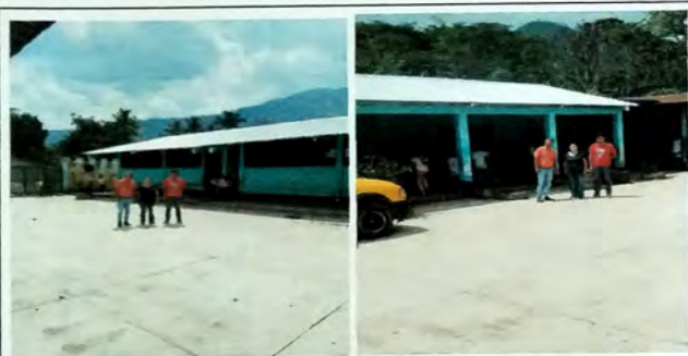
Foto 1: Vista en patio central MODULO aulas, modulo B a la derecha.
