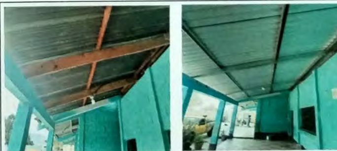
Foto 6: Vista Exterior corredor de Modulo de aulas B se cambio cubierta de lamina de zinc por lamina troquelada cal 26. Se sustituyo estructura de madera en mal estado por estructura de metal a base de vigas y costaneras
