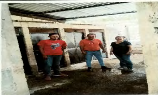
Foto 7: Vista MODULO puertas nuevas de metal instaladas en cubiculos de servicios sanitarios. Se instalo estructura de metal y lamina troquelada cal 26.
